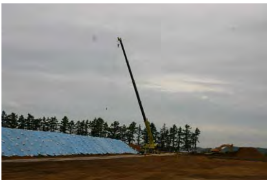
写真-3 工事の実施状況
