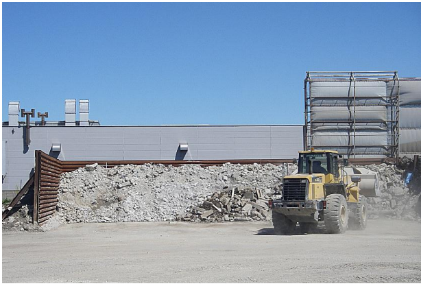
写真2 リサイクル施設のコンクリート殻存置状況
