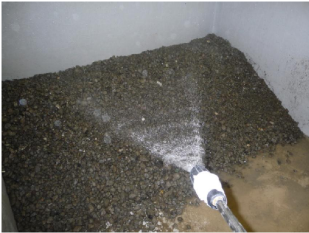
写真6 表面塩分除去作業状況
