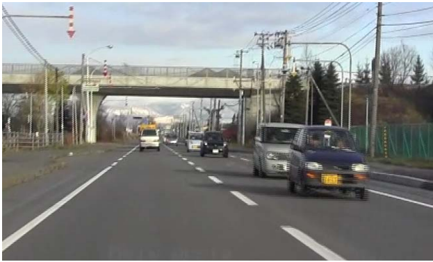
写真-2 車線の明確化
