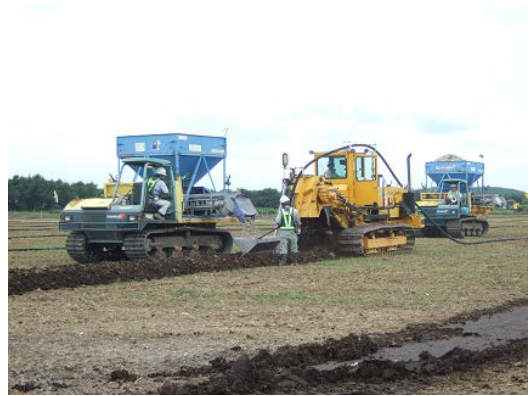
写真-8 高速自動埋設機による暗渠敷設
