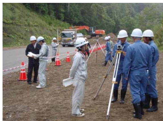
写真-2 光波測量実習【国道452号 旭川道路事務所】
