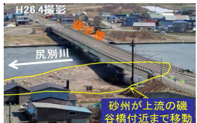
写真-3 導流堤延伸後の砂州の移動状況
