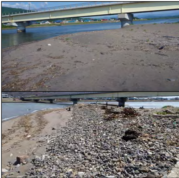
写真-4 玉石の出現状況
