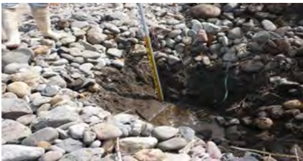
写真-5 玉石の堆積状況
