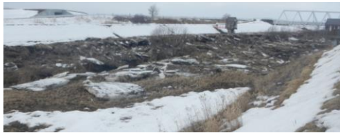
写真-1 高水敷に打ち上がっていた河氷（全景） （2018年3月12日 12:30頃撮影）
