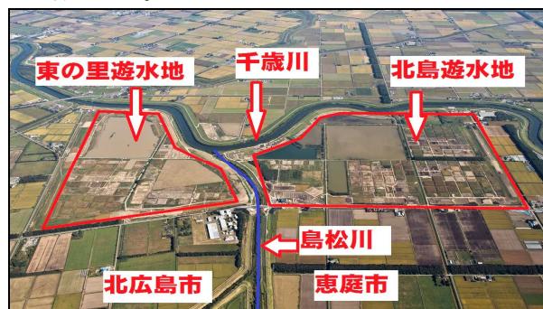
図-1 東の里遊水地及び北島遊水地と島松川
