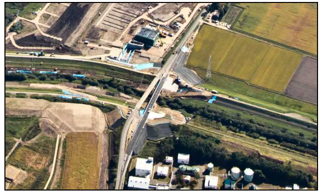
図-10 島松川築堤工事状況
