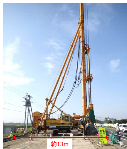
写真-1 大型機械攪拌工法(2軸式)施工状況
