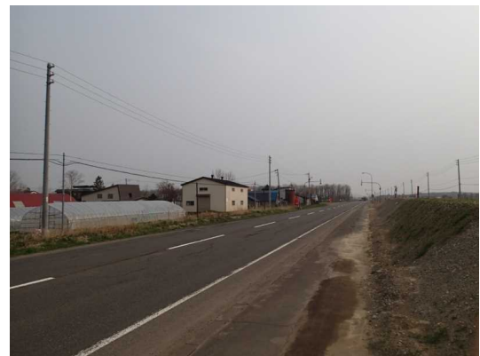
写真-3 サーチャージ盛土中の現道路面状況
