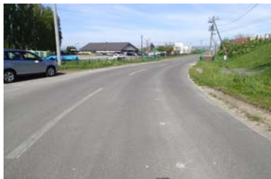
写真-6 ガラスカレット (凍上抑制層)
