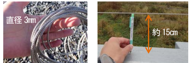
写真-4 使用したワイヤー(左) ワイヤー設置状況(右)
