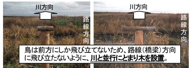
写真-2 とまり木の設置状況 S型(左)、L型(右)
