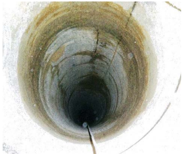
写真-7 断熱材除去後
