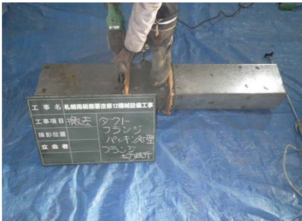
写真-9 ダクトフランジ部切断
