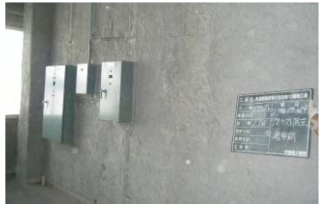
写真-1 着手前 動力制御盤
