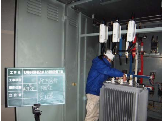
写真-13 トランス絶縁油採取 (PCB調査)
