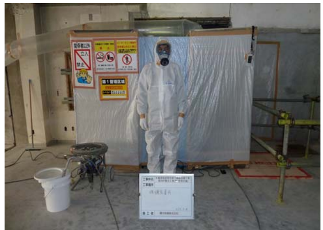
写真-11 焼却炉除洗用セキュリティゾーン設置
