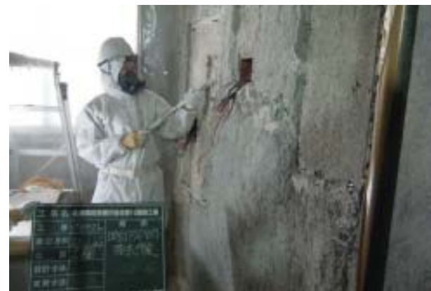
写真-3 動力制御盤裏のアスベスト除去作業
