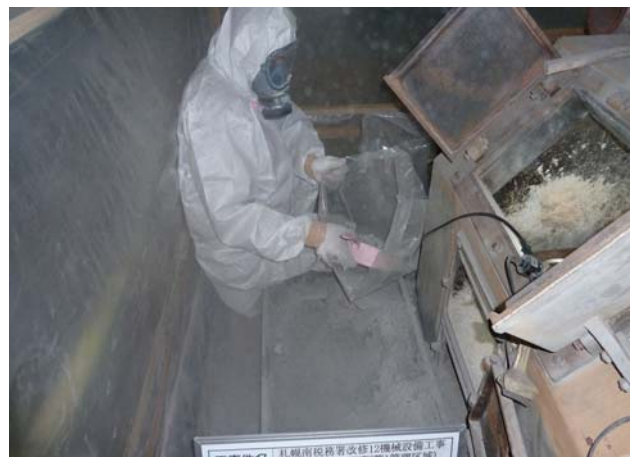
写真-12 焼却炉除洗作業（第1管理区域）
