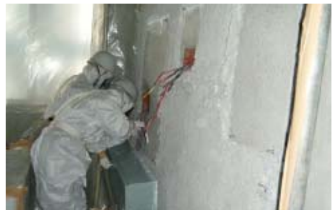
写真-2 動力制御盤撤去状況
