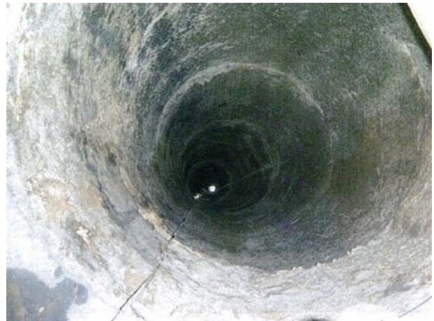
写真-6 断熱材劣化状況
