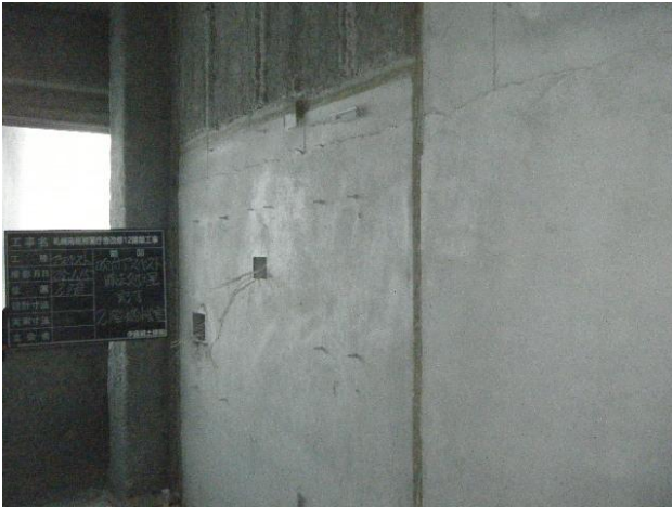
写真-4 除去完了
