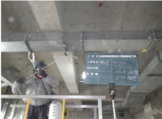
写真-8 ダクトフランジ部ガスケット湿潤化
