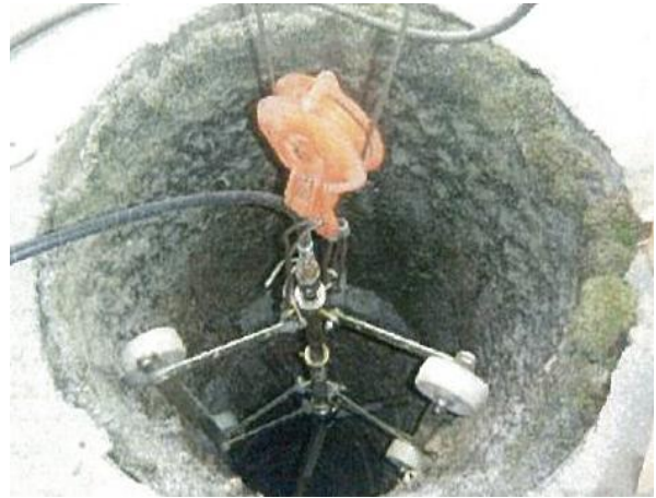
写真-5 超高压水洗浄用旋回ノズル
