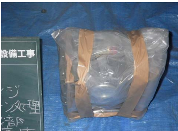
写真-10 飛散防止 梱包状況
