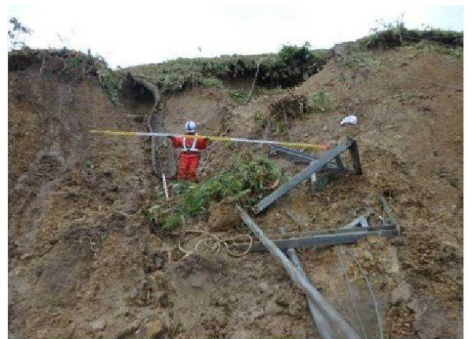
写真-3 崩壊箇所近景
