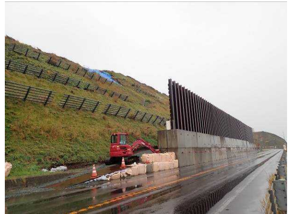
写真-5 対面通行後の状況
