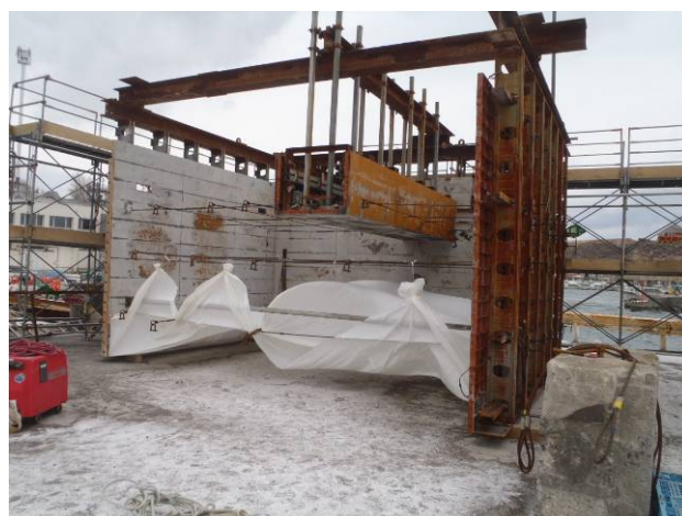
図-13 ホゾ枠設置状況
