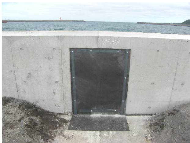
図-11 上部工目地部の防砂シート
