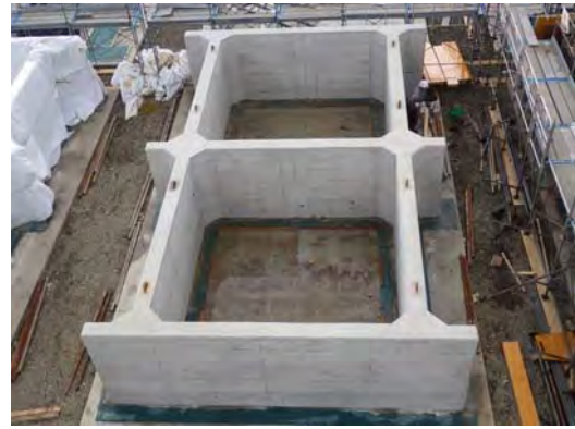
写真－4 瀬棚港における施工状況
