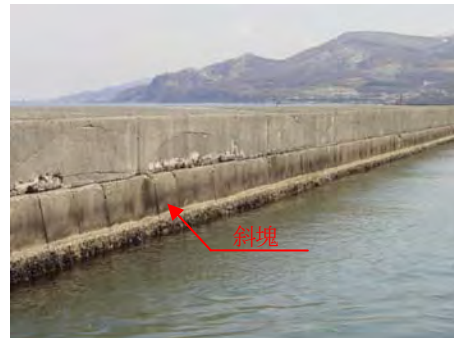
写真-2 小樽港北防波堤
