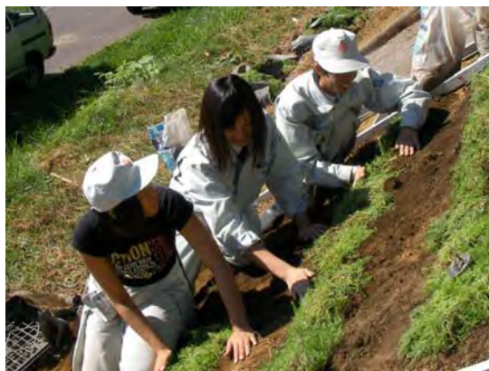
写真-12 法面にローマンカモミールを移植作業
