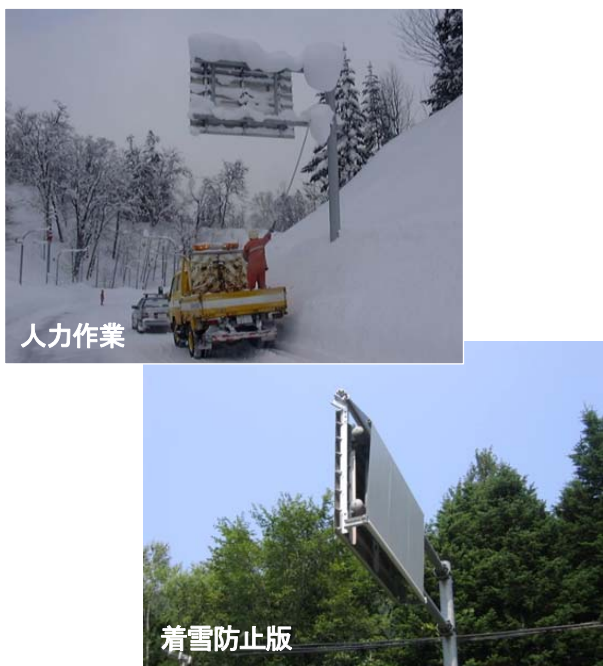
写真-6 着雪・着氷への対策状況
