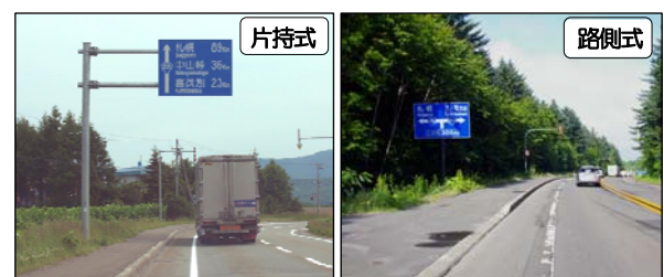
写真-2 道路案内標識の代表的な設置方式
