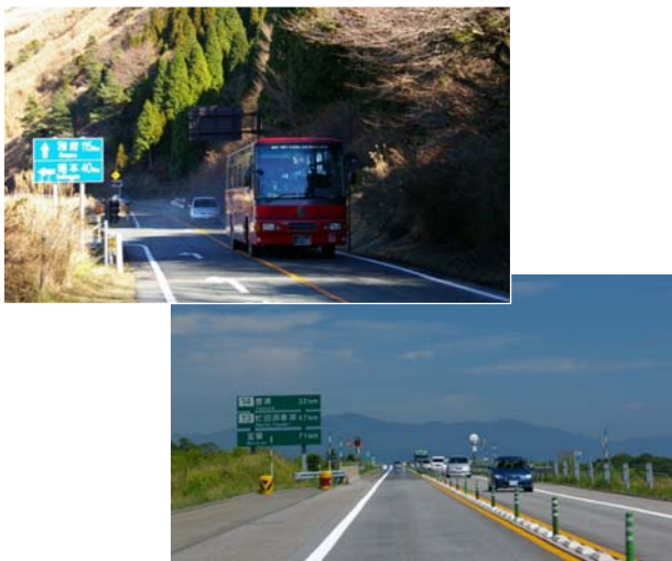
写真-3 観光地(上)と高速道路(下)での路側式の採用例
