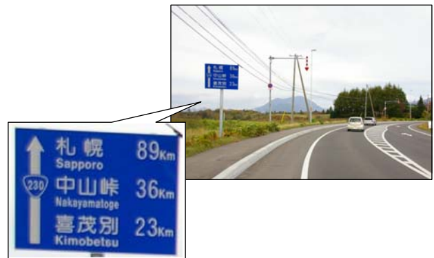
写真-11 単路部の方面及び距離の経路案内標識（106-A）
