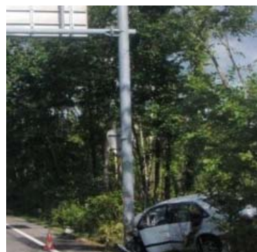
写真-7 片持式への衝突事故例
