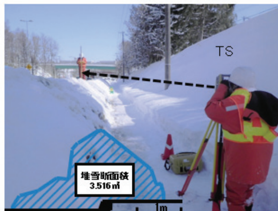
写真-2 路肩堆雪断面形状の計測状況
