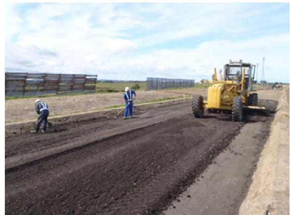
写真-1 アスファルト再生骨材 凍上抑制層 3層目敷き均し状況
