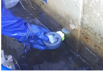
写真-4 塗膜厚測定状況
