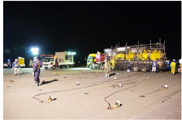
写真-1 液状化対策の実施 (A滑走路美沢川函渠部)
