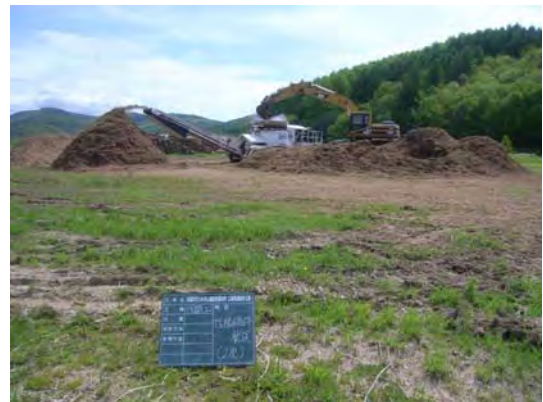
写真-14 抜根物のチップ化状況
