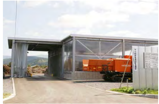
写真-12 木質原料製造設備施設（下川町提供）
