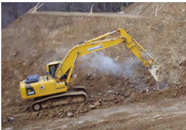
写真-2 大型ブレーカーによる岩掘削状況
