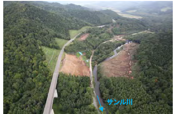
写真-4 ダムサイトの状況 (平成 25 年 9 月 6 日)
