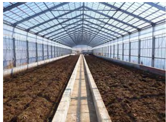
写真-15 土壌改良施設
