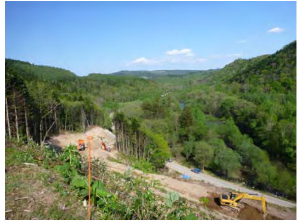
写真-3 右岸工事用道路造成状況 (平成 25 年 5 月 31 日)
