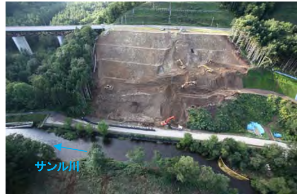
写真-5 右岸掘削状況 (平成 25 年 9 月 12 日)
