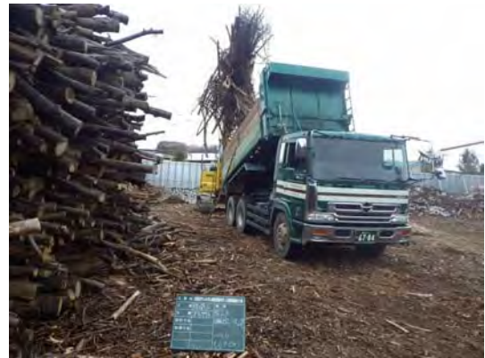
写真-13 小径木、端材等の搬出状況
