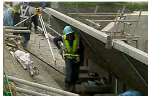
写真-1 保護コンクリートの施工状況
