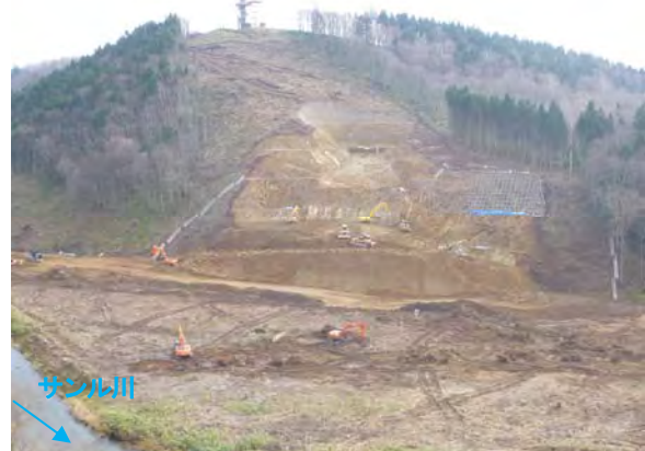
写真-6 左岸掘削状況 (平成 25 年 11 月 7 日)
