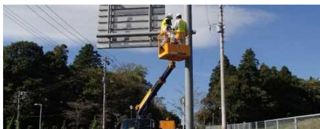
写真-3 道路標識の定期点検
