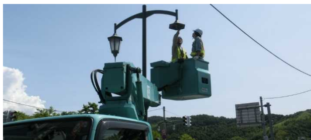
写真-2 道路照明の定期点検
