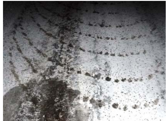
写真4 加熱水混合散布後の路面状況
