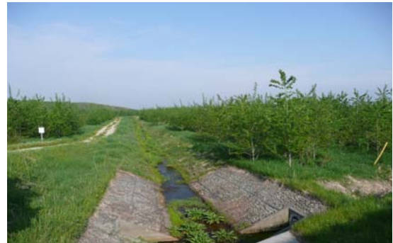
写真-1 土砂緩止林
