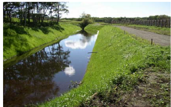
写真-2 排水調整池
