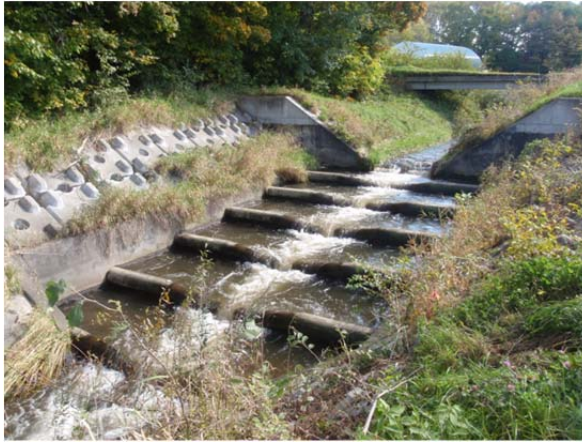
写真-1 階段型落差工の外観
