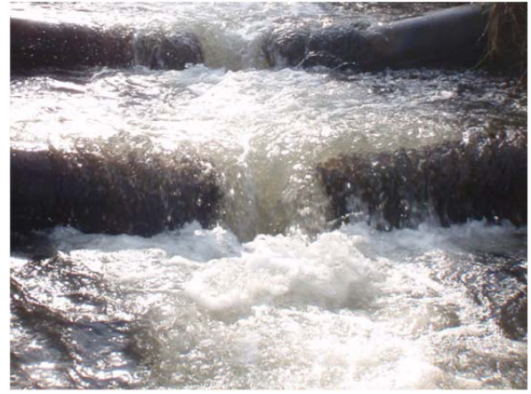
写真-2 隔壁中央部の切欠部の流水状況
