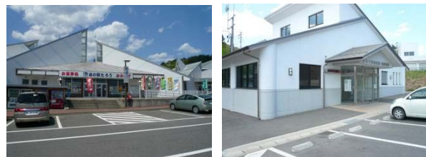
写真-8 道の駅「たろう」と防災拠点施設(道路情報館)
