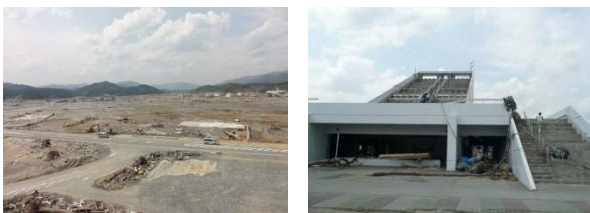
写真-3 津波を受けた「高田松原」と周辺の被災状況
