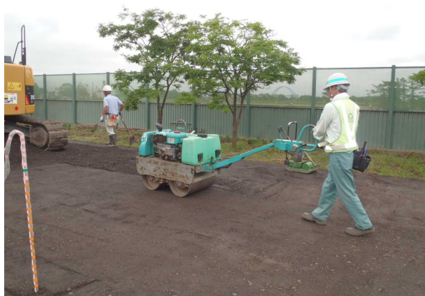
写真-1 転圧状況
