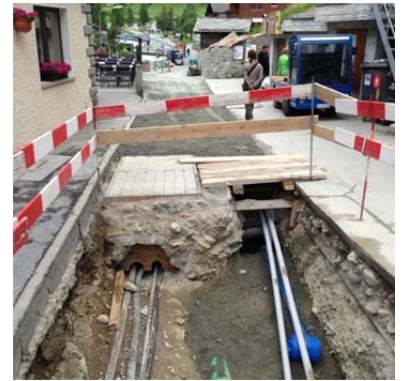
写真-1 寒冷地における浅層埋設施工事例 (スイス)
