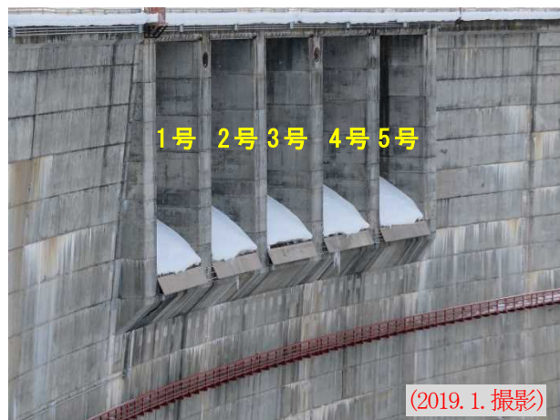
図-15 クレストゲート下流面端部の改善状況
