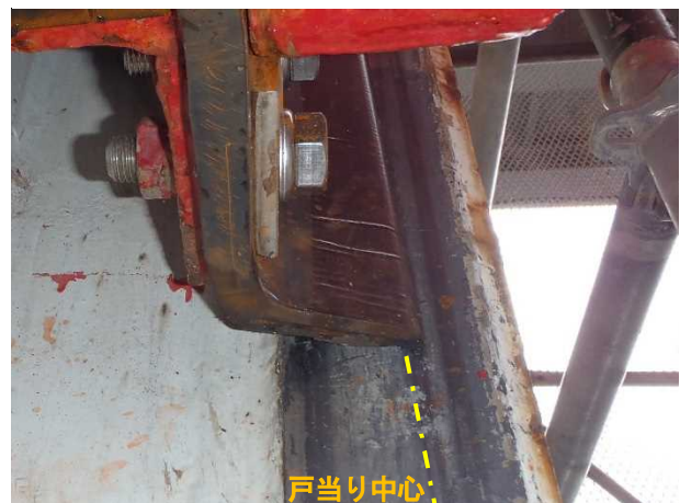
図-11 水密ゴム位置状況（交換後）
