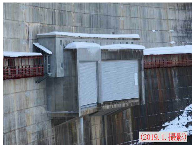
図-14 バルブ室上部の改善状況
