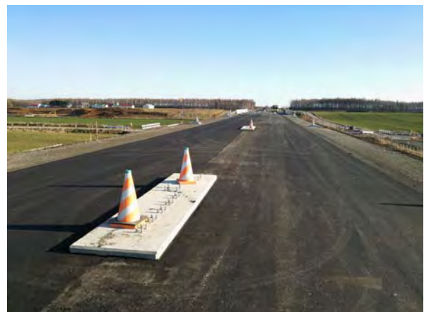
写真-3 端末基礎完成写真
