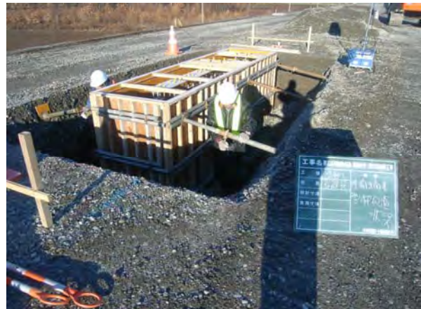
写真-2 端末基礎施工状況
