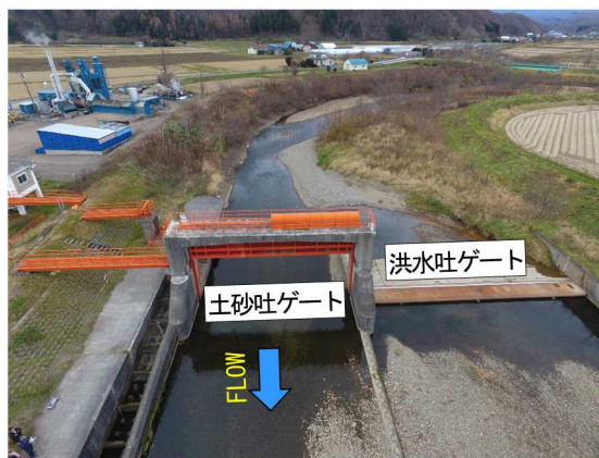
写真-1 丹羽頭首工全景
