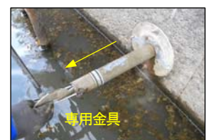
写真-21 内挿管引抜き
