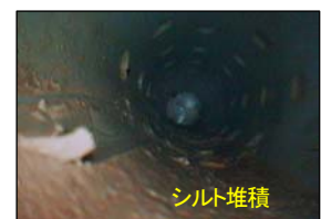
写真-19 内挿管内状況
