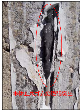
写真-12 止水ゴムの突出
