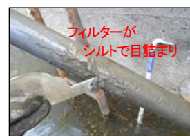
写真-20 内挿管の状態
