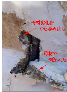
写真-10 シーリング表面
