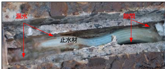
写真-2 内部の水膨張材の状況
