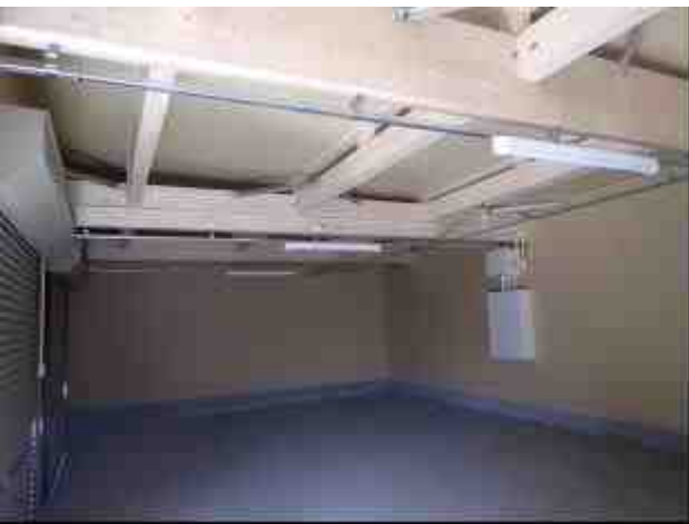
図-6 車庫・集成材梁の架構状況
