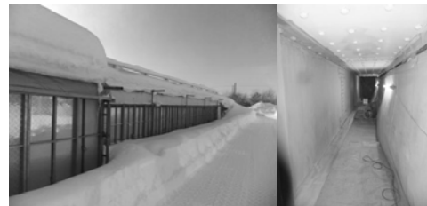
写真-1 養生状況
