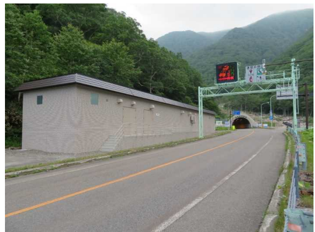
写真-5 復旧後の新第2電気室全景
