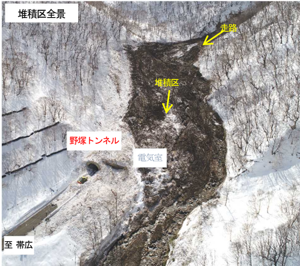
※1) 写真-1 野塚トンネル雪崩堆積区間 全景
