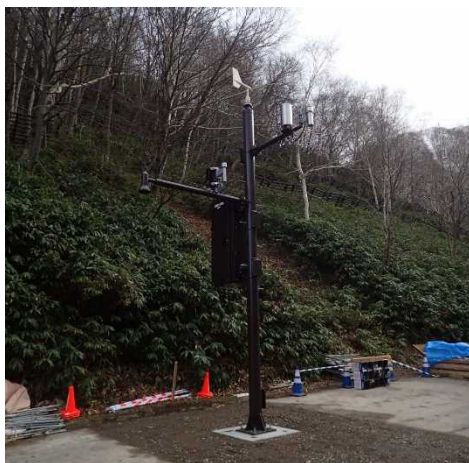
写真-6 復旧直後の屋外型気象観測設
