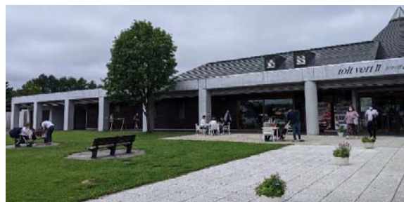
写真-8 施設前の緑化した園地の休憩場所の例
