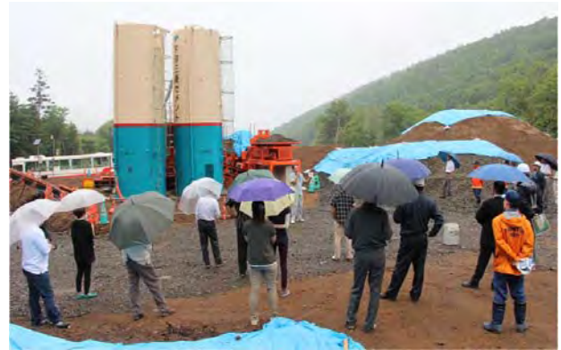
写真-8 砂防工事現場の説明
