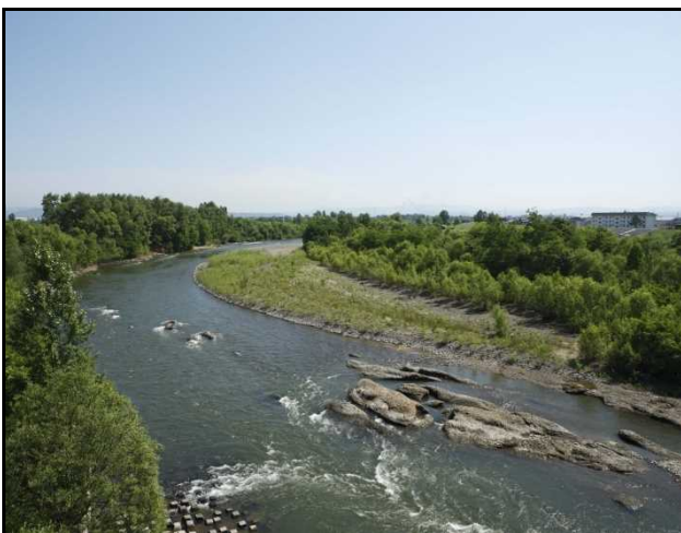
図-5 施工前の河川の状況
