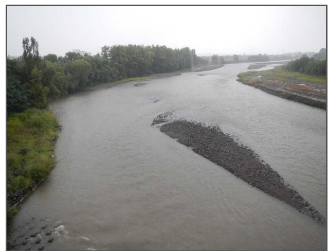
図-6 施工後の河川の状況
