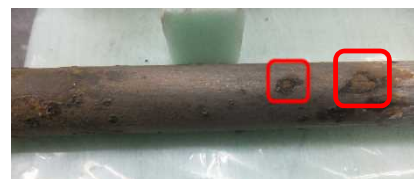
写真-6 腐食状況例（ケース3-1、塩分吸着剤 塗布厚1mm）
