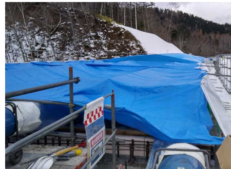
写真-1 養生状況
