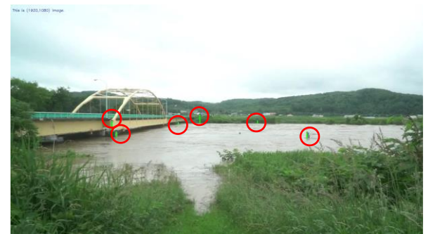
図-6 地上カメラによる標定点
