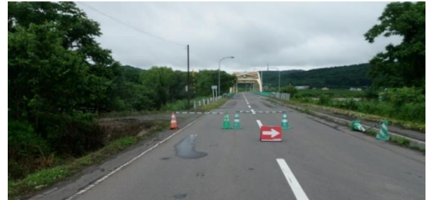
図-4 納内橋の通行止め（平成30年7月3日11時）
