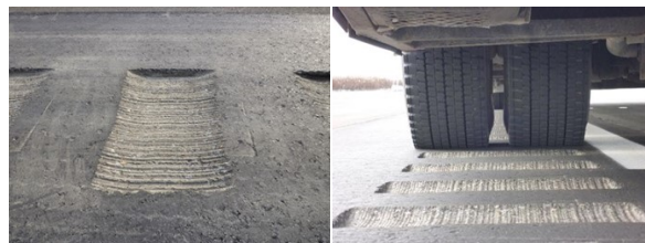
写真-4 推奨規格 (横幅 A=500mm、深さ t=18mm)
