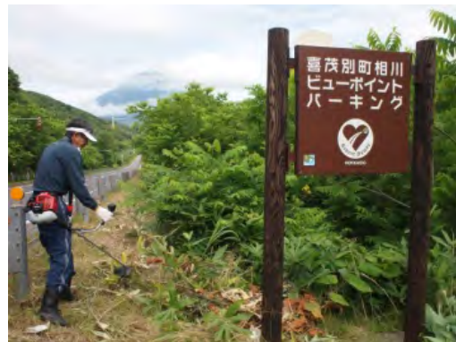
写真-3 駐車帯周辺の草刈りの様子 (喜茂別町相川地区)
