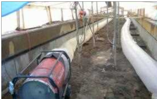
写真-15 ジェットヒータによる仮囲い内の気温保持
