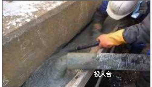
写真-11 コンクリートの打設状況
