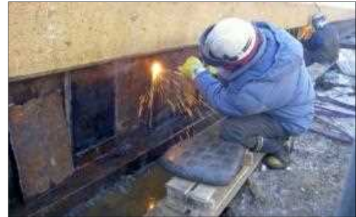
写真-6 ウェブ部の取り替え作業状況
