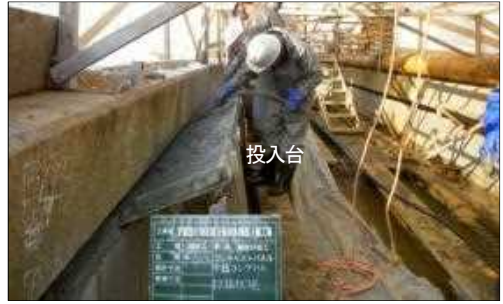
写真-10 コンクリート投入台の使用状況
