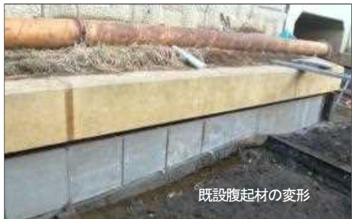
写真-9 腹起し変形部のパネル組立
