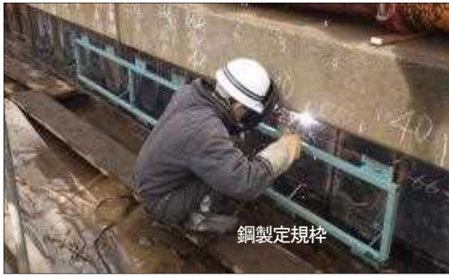
写真-7 鋼製定規枠を用いた金具溶接
