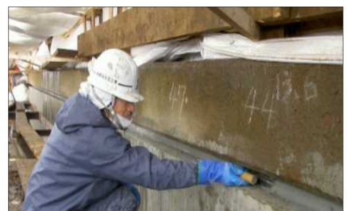
写真-12 ポリマーセメントの施工状況
