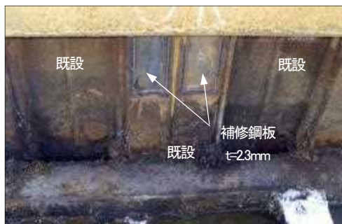
写真-4 ウェブ部の部分補修の例
