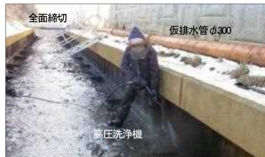
写真三 水替え後の高圧洗浄
