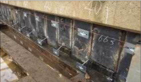
写真-8 接続金具の設置完了
