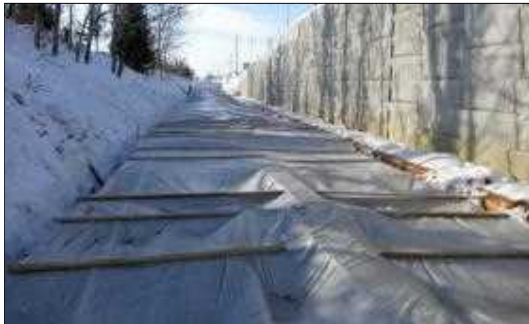
写真-14 雪寒仮囲いの設置状況
