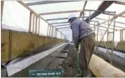
写真-13 コンクリート露出面の湿潤養生
