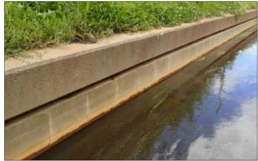
写真-17 完成（通水）状況
