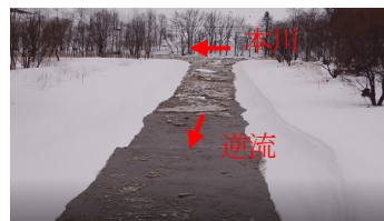
写真-2 アイスジャムによる樋門吐口水路への逆流（2018年3月、左：常呂川、忠志25号樋門、右：網走川、昭野樋門）
