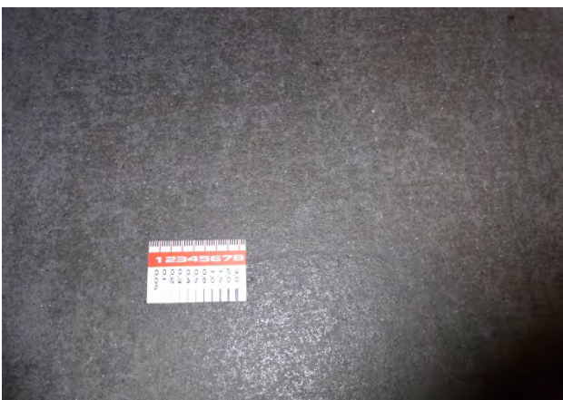
写真-3 施工前の路面状況
