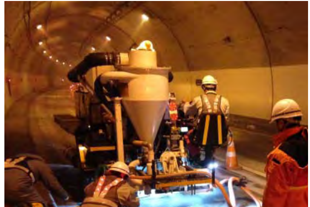
写真-4 DG施工機械
