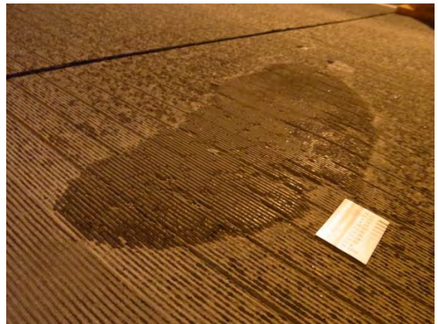
写真-12 樹脂モルタルによる穴埋め箇所
