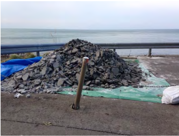
写真-7 濁水の脱水ケーキ(水はDG施工に再利用)
