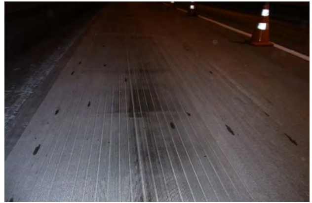
写真-10 わだち部が削り残っている
