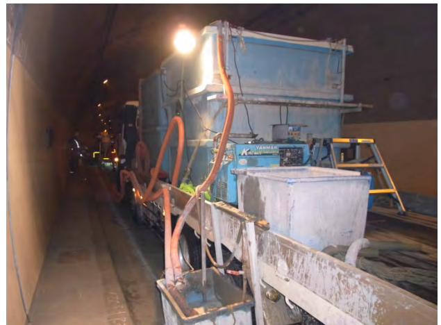
写真-5 トラック（濁水タンク（手前）、水タンク（奥））
