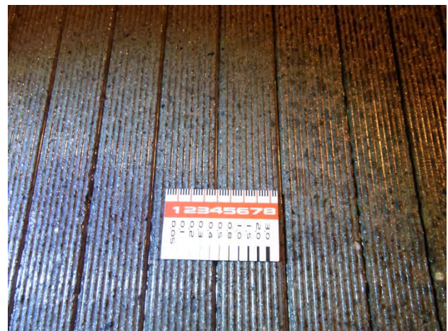
写真-1 DG施工後の表面の仕上り
