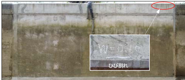
写真-2 A工法の用水路側壁面
