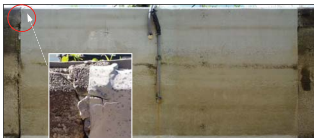
写真-4 C工法の用水路側壁面
