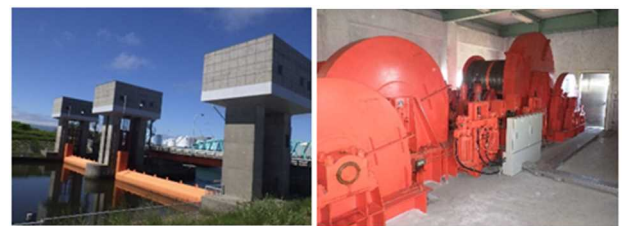
図-9 水門全景（左）と開閉装置（右）
