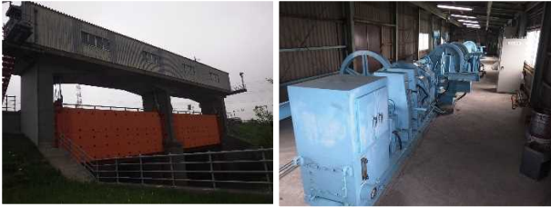
図-13 水門全景 (左) と開閉装置 (右)
