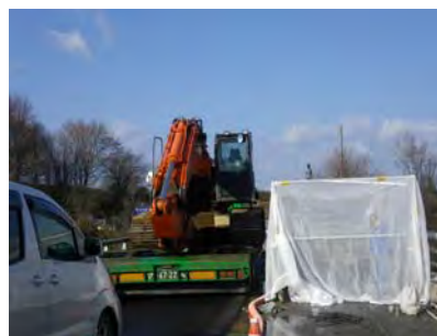
写真-5 片側交互通行状況
