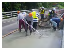
写真-8 早強コンクリート打設状況
