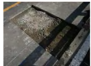
写真-2 第5径間の床版上面
