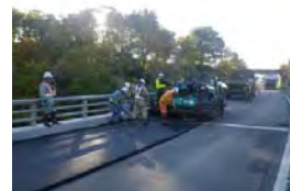
写真-10 舗装敷設状況
