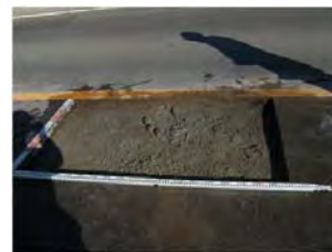
写真-1 第1径間の床版上面
