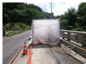
写真-7 WJはつり状況
