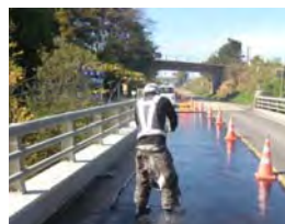
写真-9 橋面防水状況
