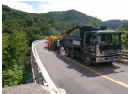
写真-6 路面切削状況
